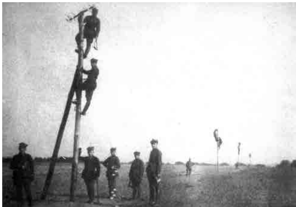
Telegrafści podczas budowy stałej linii telefonicznej
